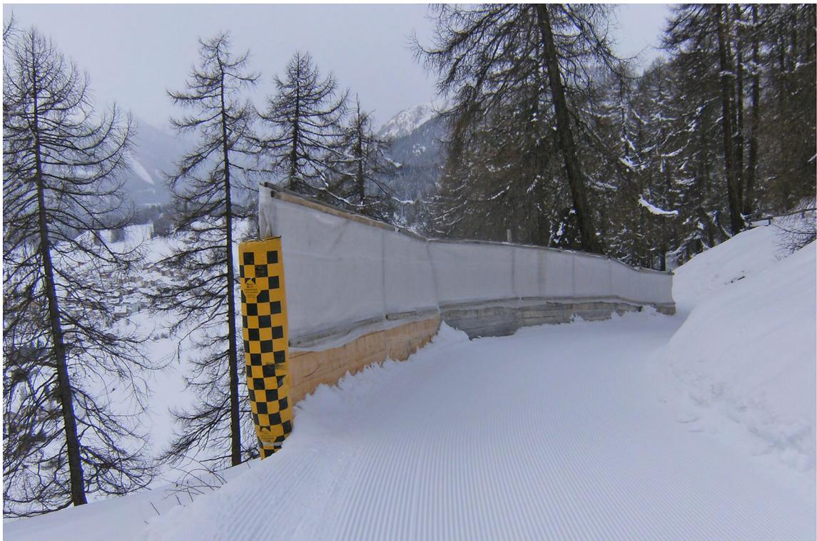
Abbildung 9: Absturzsicherung mit Schutz gegen Sonneneinstrahlung in Scuol
