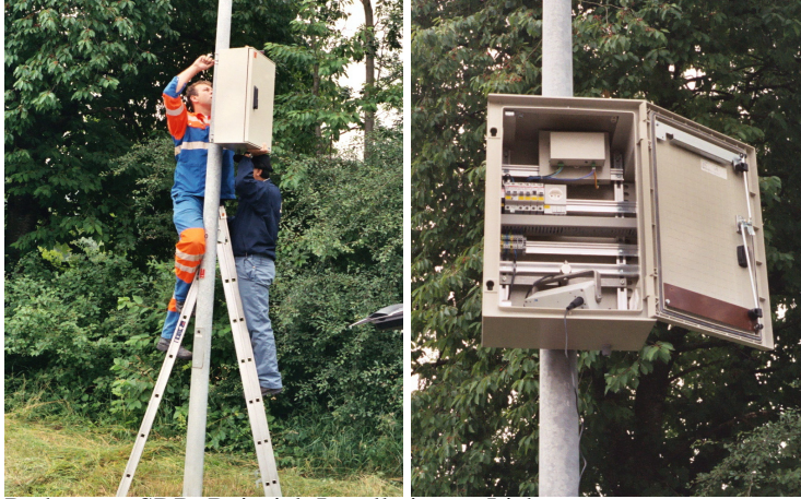
Radargerät SDR, Beispiel: Installation an Lichtmast
